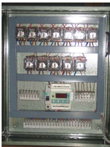
Πίνακας αυτονομίας με διαφορικό θερμοστάτη και αποθήρμανση στην τελευταία ηλεκτροβάννα
