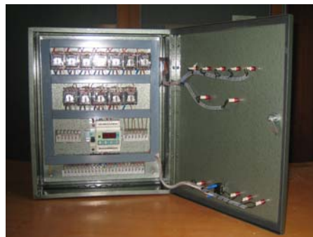
Πίνακας αυτονομίας με διαφορικό θερμοστάτη και αποθήρμανση στην τελευταία ηλεκτροβάννα
